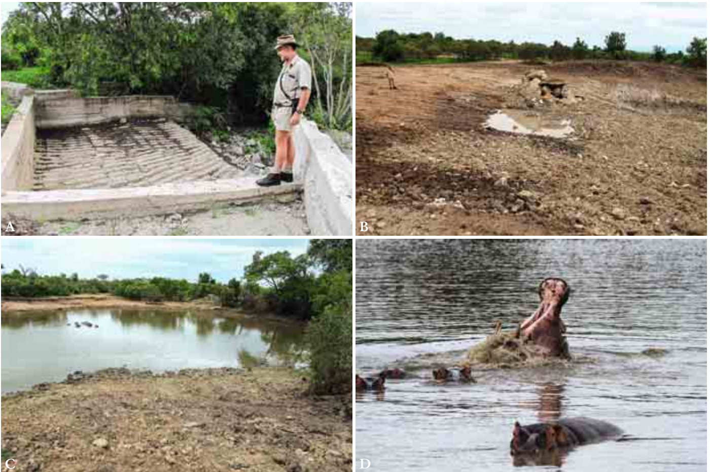
Abb. 6: (A) Mick Reilly vor dem fertiggestellten Einlaufbauwerk gegen die Erosion. (B) Vier Meter tief ausgebaggerter Stausee im Mkhaya Reservat. (C) Kleiner wieder gefüllter Stausee mit Flusspferden – die Dammwand wurde mit dem Aushub erhöht. (D) Flusspferde genießen nach der Sanierung die größere, ihnen zur Verfügung stehende Wassermenge. (A) Mick Reilly in front of the finished spillway and plunge area against continuous erosion. (B) Four meters deep excavation of the dam floor in the Mkhaya Reserve. (C) Small refilled dam with hippos – the dam wall has been raised with the excavated material. (D) Hippos enjoy the larger water volume after the restoration of the dam. (Fotos: A. Sliwa)
