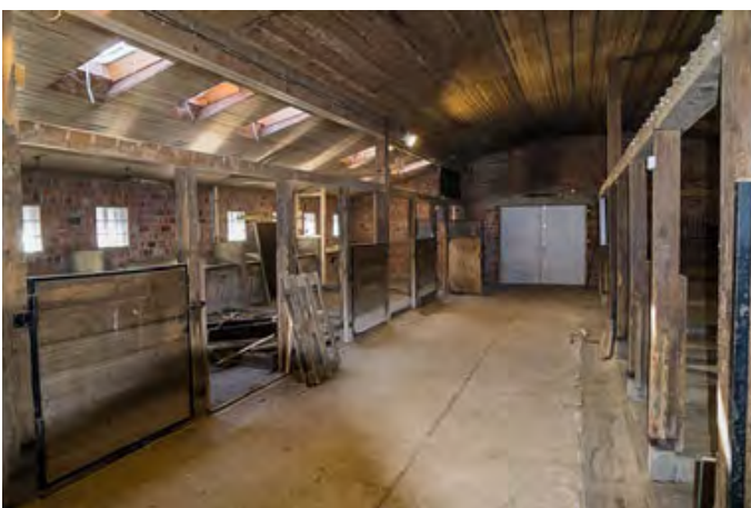
Abb. 115: Für den Umbau des ehemaligen Pferdestalles in ein Bantenghaus musste dieser komplett entkernt werden.
